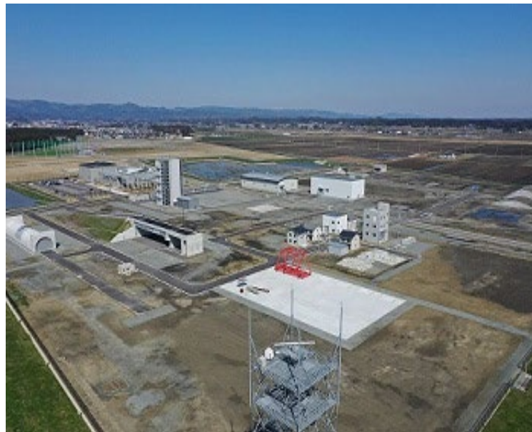
福島ロボットテストフィールド 全景
